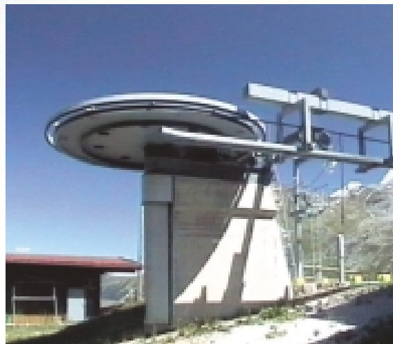
Bergstation der 6er-Sesselbahn mit Unterflurantrieb.
